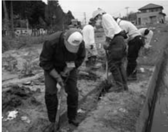
南相馬市鹿島地区内排水溝の土砂除去作業
