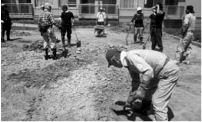
三条市内特養施設の土砂除去作業
