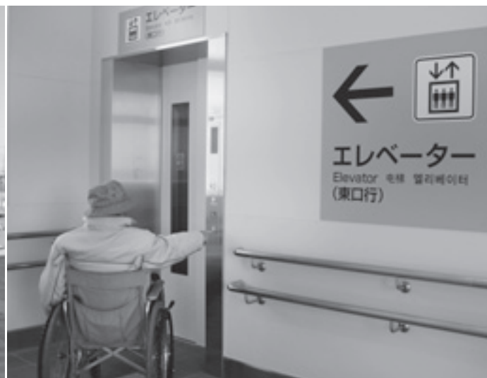
東西にエレベーターができました ストレッチャーが入れるほどの広さです
