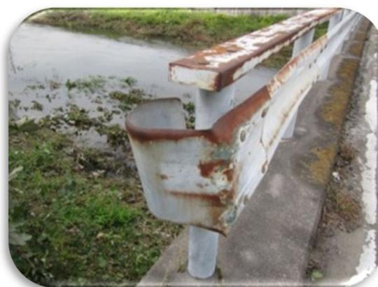
写真-1.2 ガードレール塗装劣化
