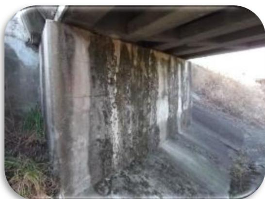
写真-1.3 伸縮装置からの漏水
