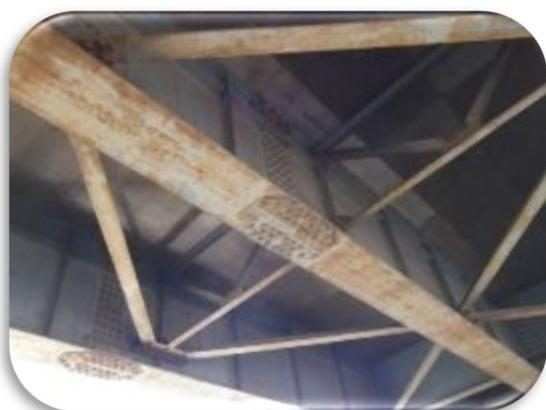
写真-1.1 主桁塗装劣化
