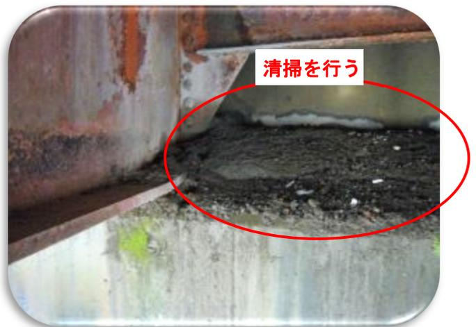
写真-3.2 沓座土砂堆積
