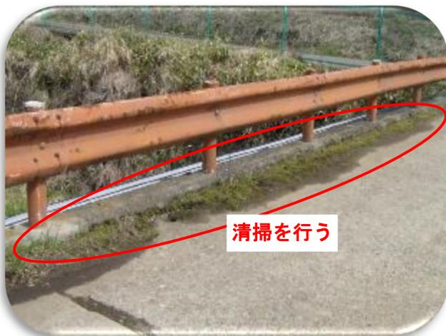
写真-3.1 橋面土砂堆積
